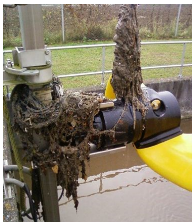
Verunreinigtes Rührwerk der Kläranlage Mauerkirchen
