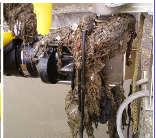
Verunreinigtes Rührwerk der Kläranlage Mauerkirchen
